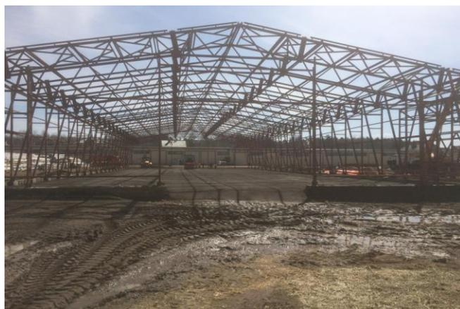
Здание монтируется на подготовленные фундаменты. Если грунт- тугопластичная глина, то здание монтируется на буронабивные сваи диаметром 800 мм. Задание на фундамент разрабатывает ООО"МеталлКаркас", и предоставляется после заключения договора.
